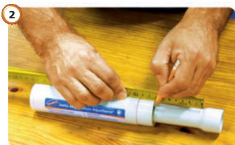
A Junta de Expansão Aquatherm® TIGRE deve ser instalada com o pistão parcialmente estendido. Faça a marcação do comprimento de acordo com a ilustração da posição do pistão e a tabela 3 (também constantes na Junta de Expansão Aquatherm® TIGRE.)
