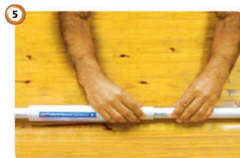
Solde as duas extremidades da Junta de Expansão Aquatherm® na tubulação. Instale dois apoios próximos da junta para facilitar o livre deslocamento do pistão.
