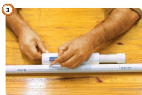
Posicione a Junta de Expansão Aquatherm® TIGRE com o pistão devidamente estendido no local onde será instalada. Faça as marcações de corte da tubulação nos locais coincidentes com o fundo das bolsas da Junta de Expansão Aquatherm® TIGRE.
