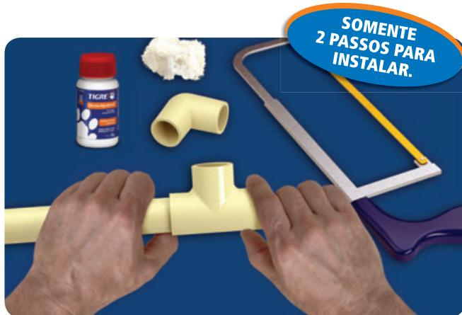
Passo 2: Encaixe de uma vez as extremidades a serem soldadas, dê  $\frac{1}{4}$  de volta e mantenha a junta sob pressão manual por aproximadamente 30 segundos, até que o adesivo adquira resistência.
