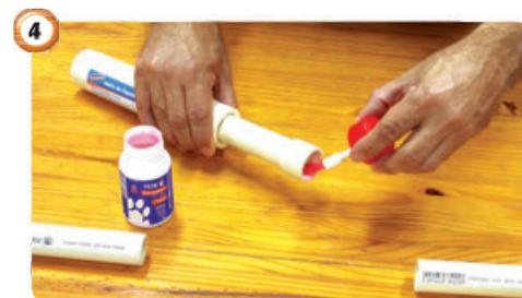
Aplique o Adesivo Aquatherm® nas bolsas da Junta de Expansão Aquatherm® e instale-a no trecho da tubulação horizontal ou vertical.
