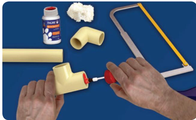
Passo 1: Com o auxílio de um pincel, aplique o Adesivo Aquatherm® ou o Adesivo Especial TIGRE na conexão e em seguida na ponta do tubo.
